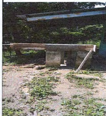
Foto 4: Base para colocar sistema de agua en sanitarios
