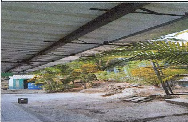
Foto 3: colocacion de canales de agua
