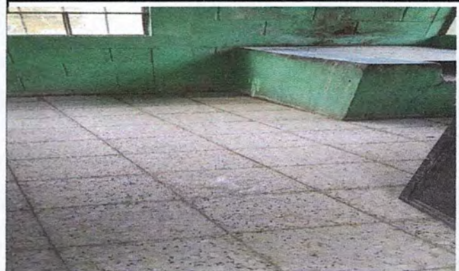
Foto 2: cambio de plancha y piso
